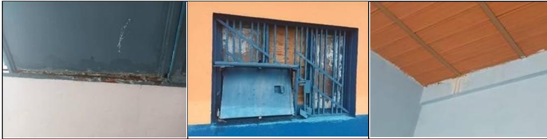
La vista interior del espacio muestra condiciones generales de conservación que requieren atención. Se identifican elementos con signos de desgaste, como marcos de puertas y ventanas con presencia de corrosión, así como una filtración puntual en la cubierta. El área no cuenta con luminarias instaladas, lo que limita su funcionalidad actual. Estas observaciones reflejan la necesidad de intervenciones básicas para adecuar el espacio a usos operativos seguros y eficientes.
